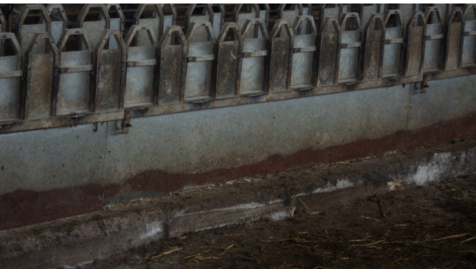
Αμφίπλευρη φάτνη μηχανικής μεταφοράς χονδροειδών ζωοτροφών
