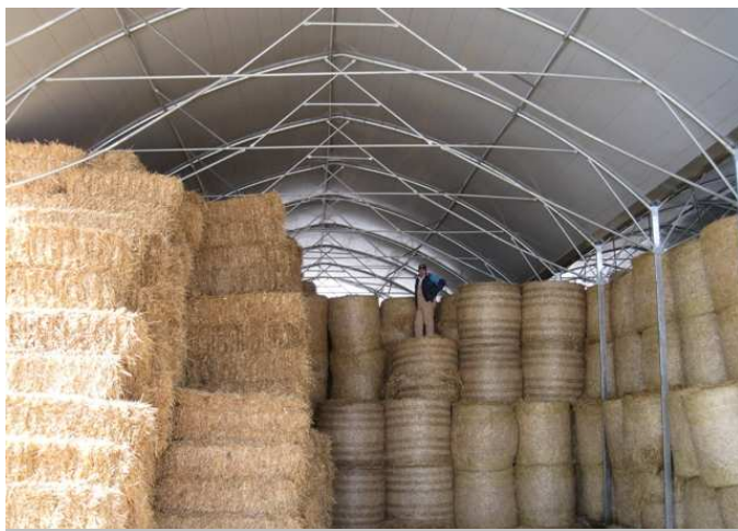
Εικόνα 6.4 Αποθήκη χονδροειδών ζωοτροφών θερμοκηπιακού τύπου. Πηγή: http://www.geotherm.gr/site/default.asp?pid=8715&sid=8718&langid=12
