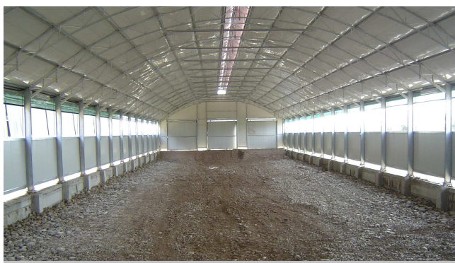
Εικόνα 7.3 Ημιτελές προβατοστάσιο θερμοκηπιακού τύπου (Περιοχή: Πηγή Τρικάλων).
